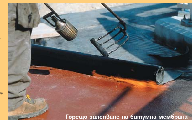
Горещо залепване на битумна мембрана
