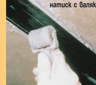
Изпитване на системата Sika® върху бетонна греда
