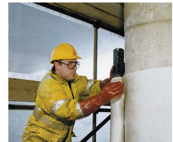
Приложение на системата от влакна Sika Wrap® за удароустойчивост на мостова колона
