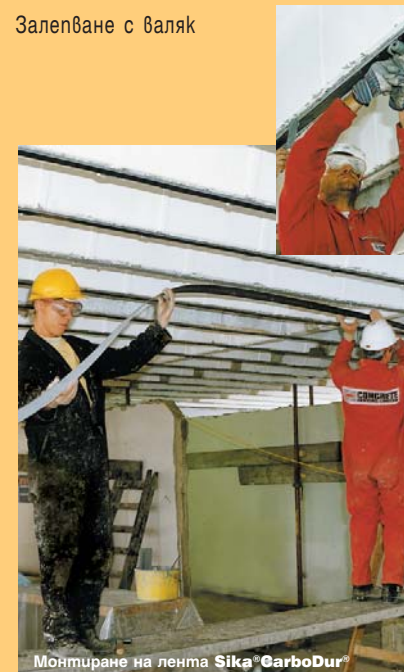
Монтиране на лента Sika®CarboDur®
