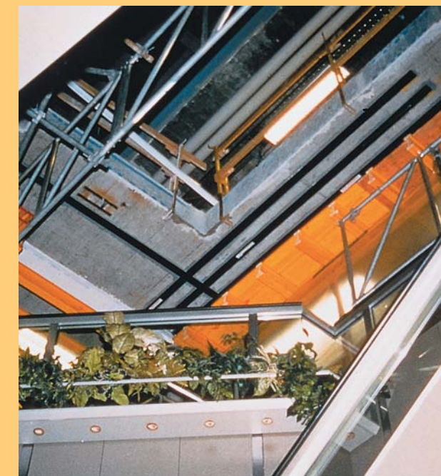
Монтиране на ескалатори
