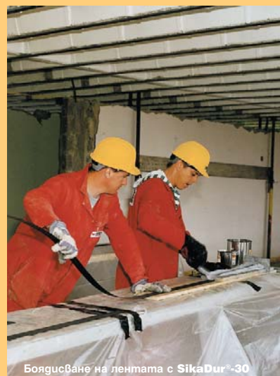
Боядисване на лентата с SikaDur®-30
