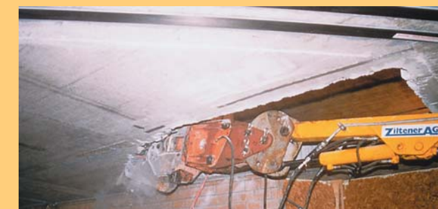
Разрушаване на плочата на паркинга след укрепване
