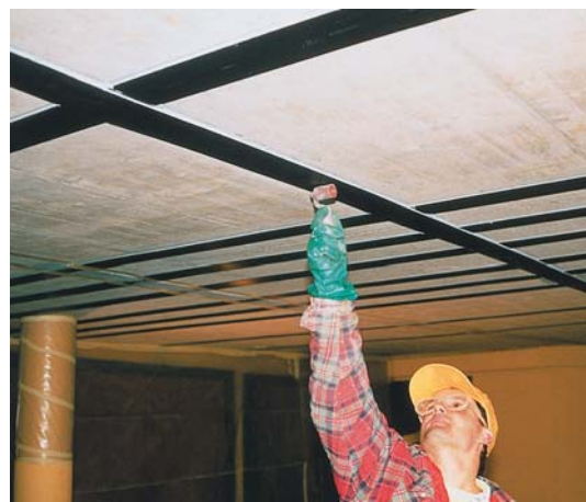
Укрепване на стоманобетонна плоча със с-ма от ленти Sika® CarboDur® (Лепило Sikadur-30 и ленти Sika® CarboDur® ).
