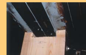
Релаксация на деформацията на гредата чрез две подпорки. Вкарване на ленти Sika®CarboDur® H514
