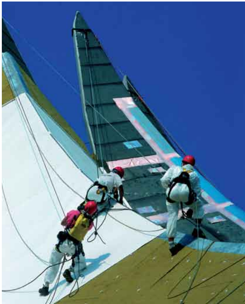
Приложение на еднослойната мембрана в „Тетродрот“, Германия
