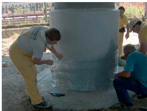
Фиг. 9.5. Бинтоване на елемента с тъканта SikaWrap-430 G.
