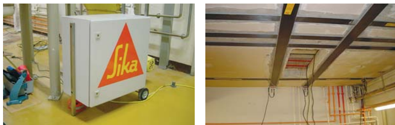
Фиг. 8.5 Бързо втвърдяване при използване на Sika нагревателно приспособление
