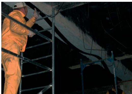
Фиг. 9.9. Монтаж на ламели SikaCarboDur S1012.
