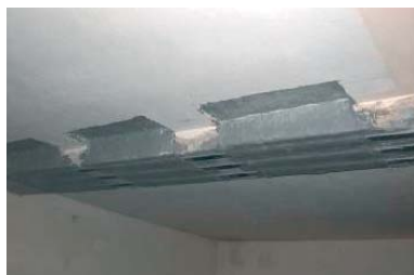
(б) Залепване и анкерирание на стоманения елемент.
