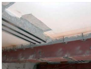
Фиг. 9.10. (а) Поемане на усилия чрез въглеродни ламели и стоманен елемент в две направления.
