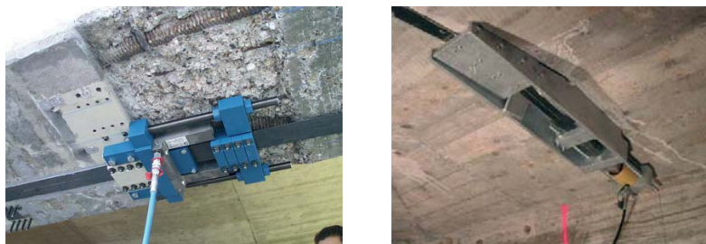
Фиг. 8.7 Sika прегварително налягане системи: (а) Sika Leoba Carbodur CFRP и (б) Sika StressHead
