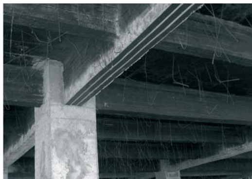
Фиг. 9.10. Усилена стоманобетонна грега.
