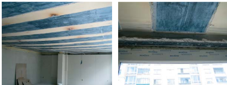
Фиг. 9.8. Усилване на стоманобетонната плоча и греда.
