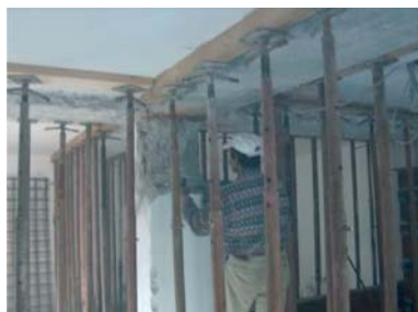
(б) Временно укрепване и разрушаване на колоната.
