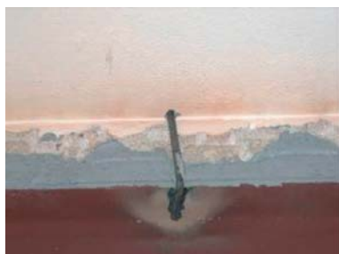
(б) Залепване и анкерирание на стоманения елемент.
