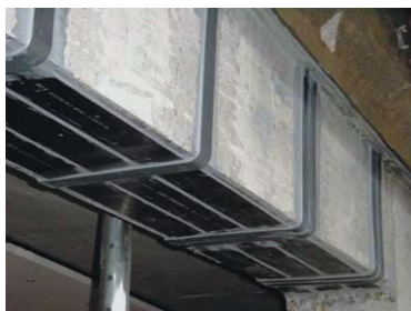
Фиг.7.1 Закотвяне на надлъжно положеня FRP материал чрез предварително изготвени L -образни ламели с въглеродни нишки.
