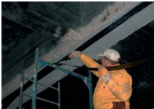
Фиг. 9.8. Залепване в опънната зона на въглеродни ламели за поемане на нов, по-голям положителен огъващ момент в сечението.
