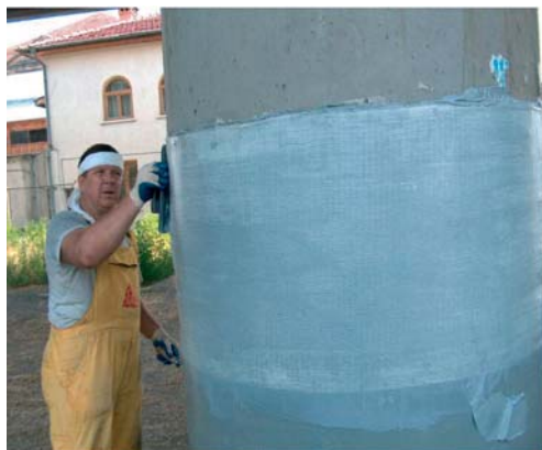
Фиг. 9.6. Възстановяване на монолитността на връзката колона - изливен пилот и увеличение на дупилността на ѝ.
