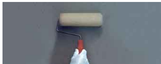
Нанасяне на покритие Sikafloor®-264 Thixo с релефен валик
