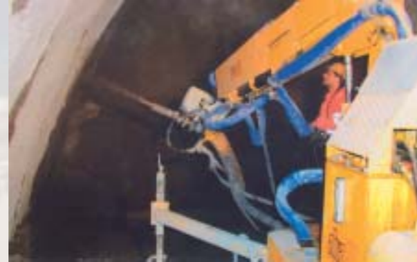
Aliva-503 система за торкретиране на малки секции
