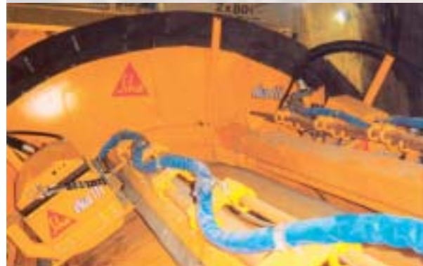
Стабилизация с торкрет при механизизирано прокарване на тунели
