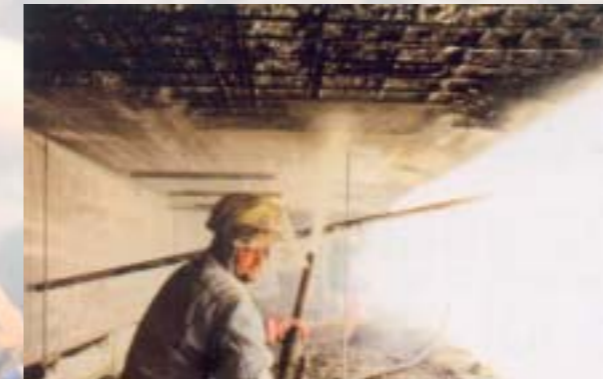
Ремонт на мостове
