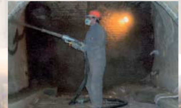
Ремонт на тунели
