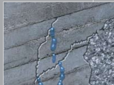
Повърхностно запечатване на бетонни конструкции
