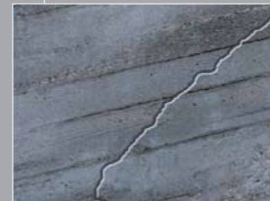
Ремонт на конструктивни пукнатини и кухини
