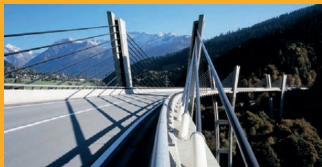
ЗАЩИТА И РЕМОТ НА БЕТОН
